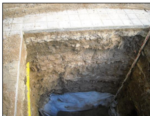
El mur UE. 313 un cop net i protegit amb geotèxtil
